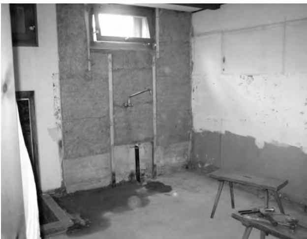
Die alte Küche ist herausgerissen.
