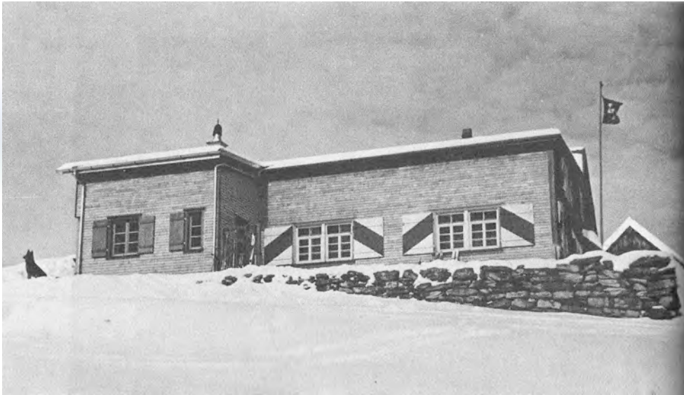
Clubhütte mit Anbau im neuen Gewand
