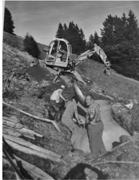
Maschinelle und manuelle Grabarbeiten.
