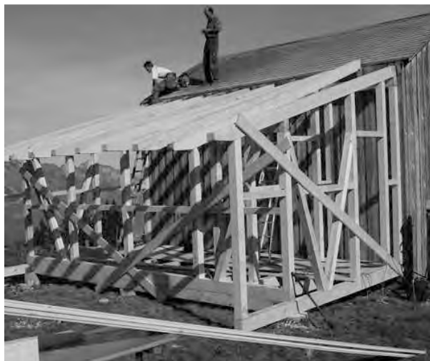
Der Holzschopf wächst - das Balkengerüst steht.
